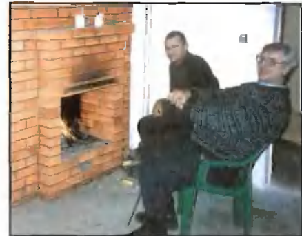
Очень довольный подрядчик, принимая работу печников, не догадался, что причиной выброса дымовых газов в комнату при растопке камина стала сложенная его рабочими труба Ø150 мм, а не 200 мм, как ему советовал каминных дел мастер
