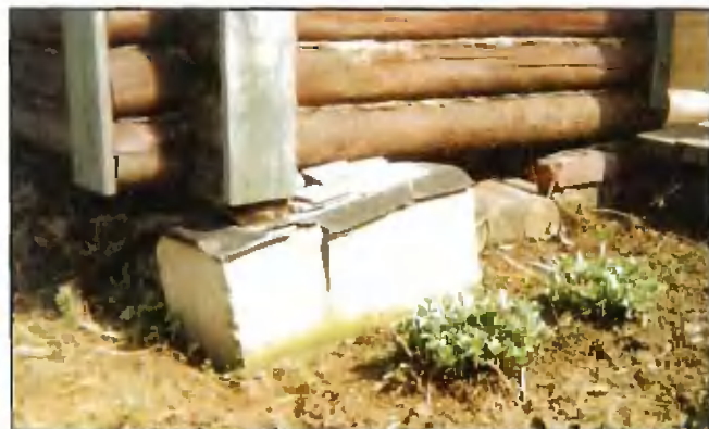
Сруб бани при больших деформациях пучения сместился с опор
